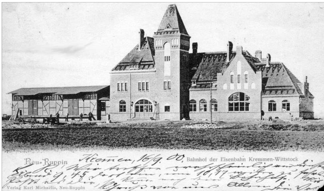
Bild 26 Straßenseite des Empfangsgebäudes der Ende 1898 eröffneten Kremmen-Wittstocker Eisenbahn mit angebautem Güterschuppen. Als diese Karte im Jahre 1900 verschickt wurde, dürfte der Bahnhofsvorplatz bereits gepflastert gewesen sein.
